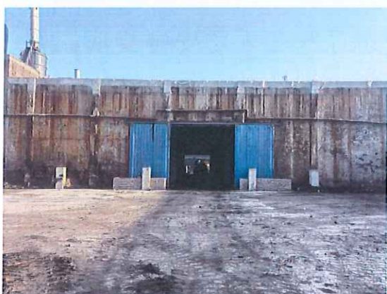
图 1 糠醛废渣棚房顶改造现场
