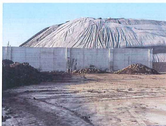
图 2 板墙建设现场
